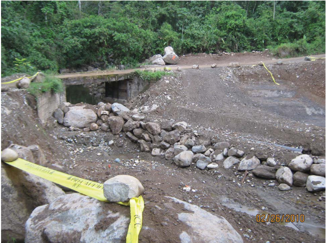
Imagen 9. Construcción en (y destrucción de) la quebrada de Veraguas. La quebrada tiene una gran importancia cultural y sirve como una fuente integral de recreación y sustento para la comunidad. Ver también Imagen 2 165 .
