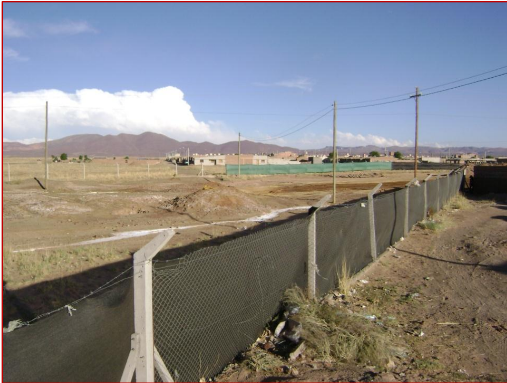
El terreno de Barrio 12 de Octubre donde se están haciendo las obras de remoción. Mantas negras y verdes fueron colocadas en partes del cercado como medida de precaución, pero no cubren todo el perímetro. José Sajama, 25 de noviembre, 2011.
